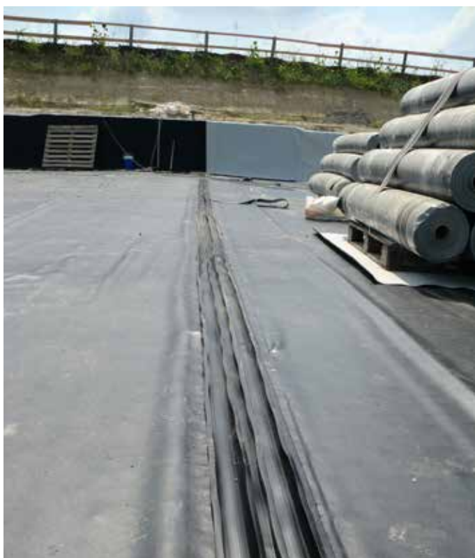
Pose d'un joint de compartimentage soudé à une membrane en PVC
