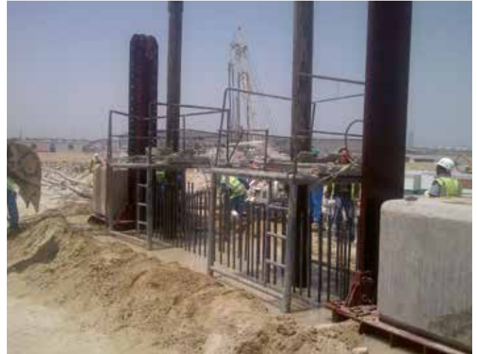
Réalisation d'une paroi moulée avec joint Waterstop
