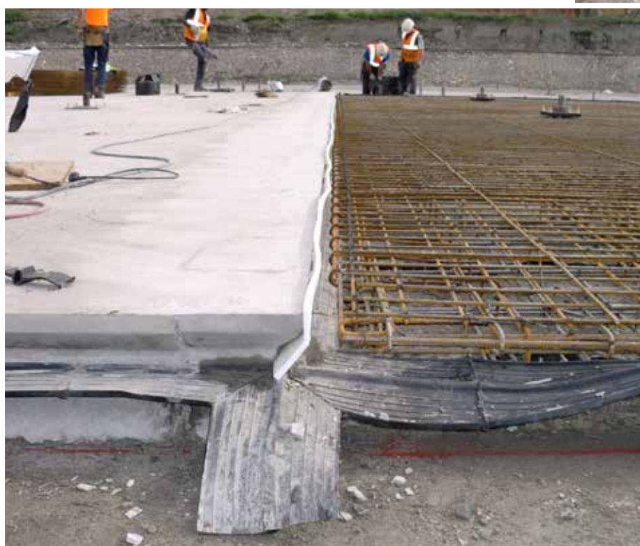
Utilisation du joint WATERSTOP BFO dans une reprise horizontale
