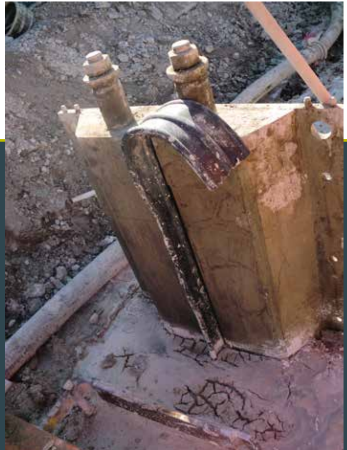
Joint Waterstop dans la palplanche (stop end)
