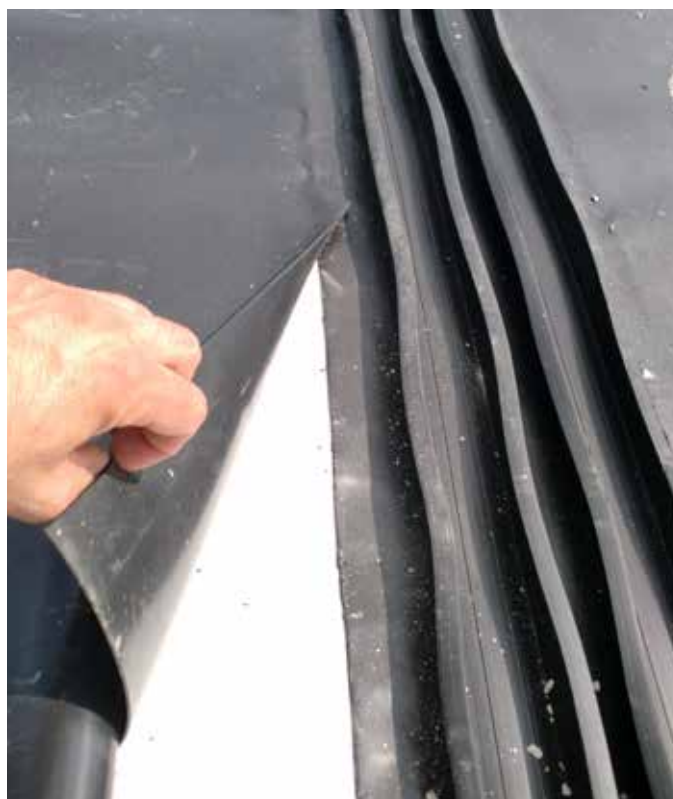
Pose d'un joint de compartimentage soudé à une membrane en PVC
